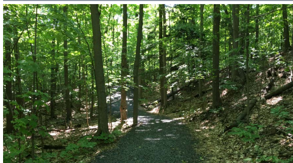
Aménagement et mise aux normes d'un sentier, Sainte-Julie
